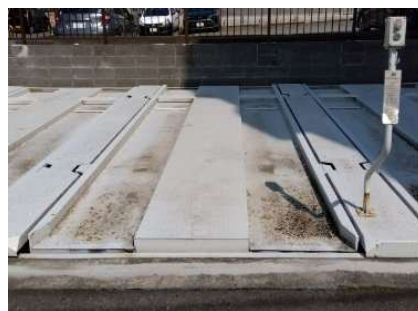
立駐機のパレット (立ち入り許可のある現場のみ)
